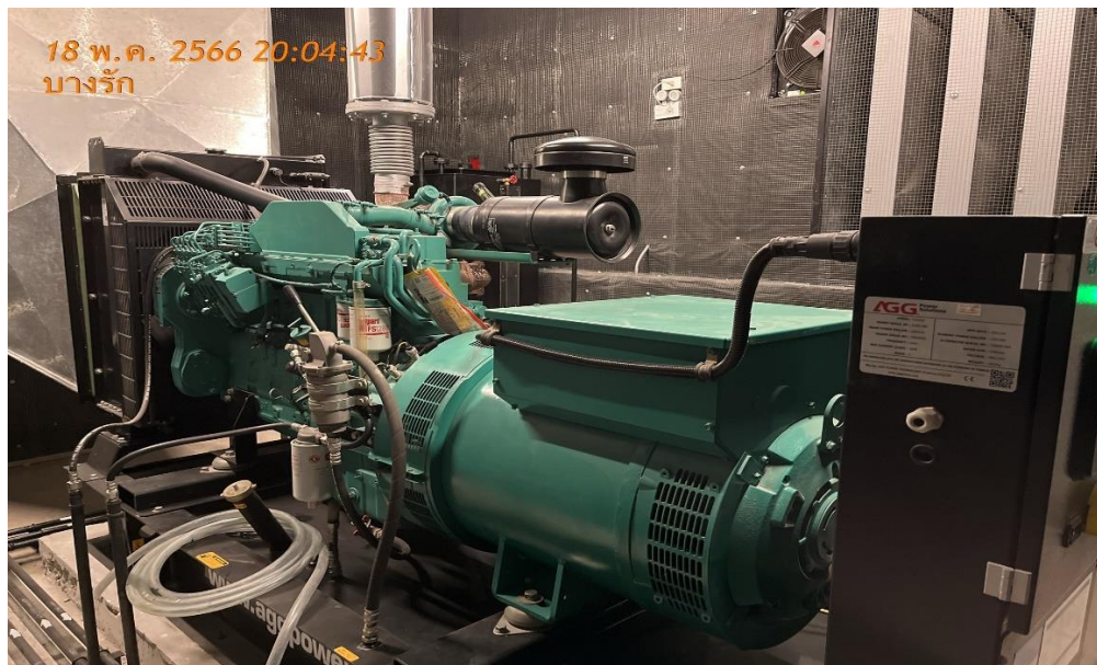
รูปที่ 2.5.6-4 เครื่องกำเนิดไฟฟ้าสำรอง
