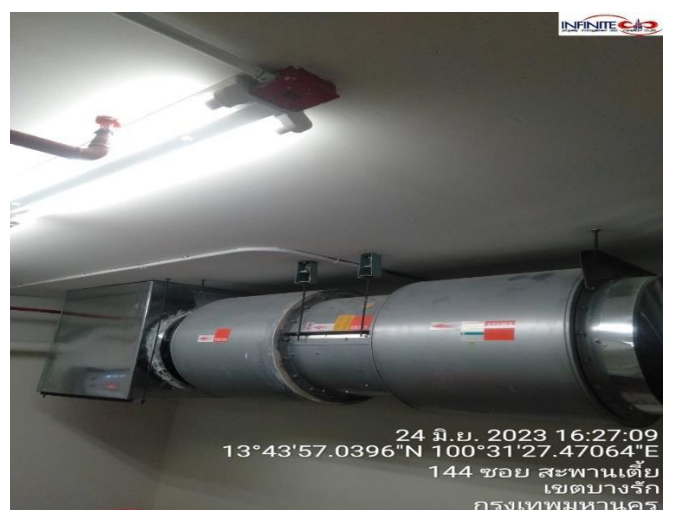
รูปที่ 2.5.8-6 พัดลมอัดอากาศ
