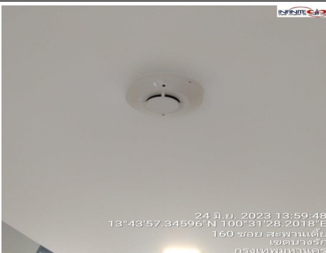
รูปที่ 2.5.7-11 อุปกรณ์ตรวจจับควัน (Smoke Detector)
