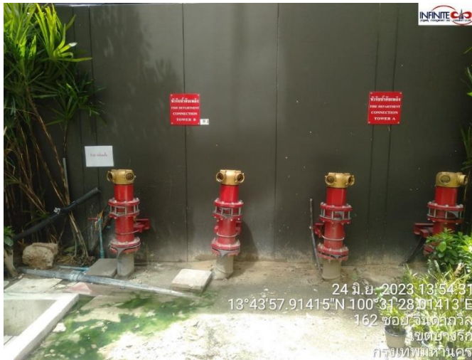
รูปที่ 2.5.7-2 หัวรับน้ำดับเพลิงภายนอกอาคาร
