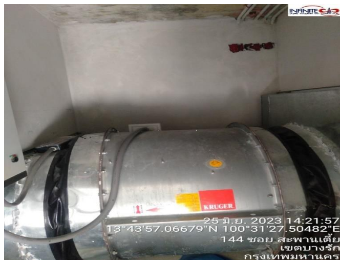
รูปที่ 2.5.7-19 พัดลมอัดอากาศ
