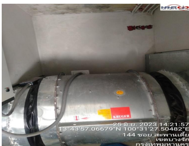
รูปที่ 2.5.8-5 พัดลมอัดอากาศ
