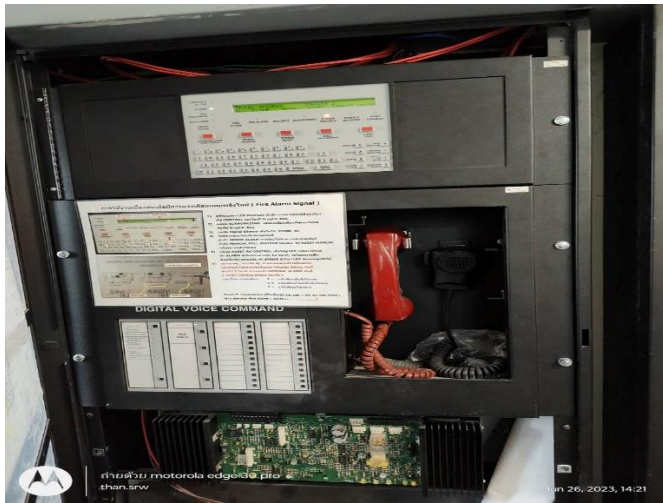
รูปที่ 2.5.7-9 ตู้ควบคุมระบบแจ้งเตือนเหตุเพลิงไหม้อาคารA
