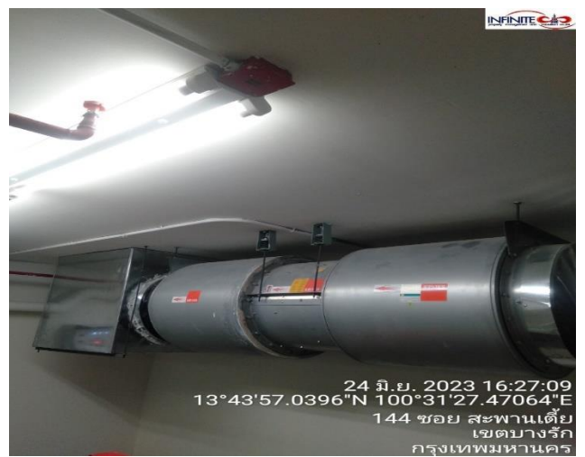
รูปที่ 2.5.7-20 พัดลมอัดอากาศ
